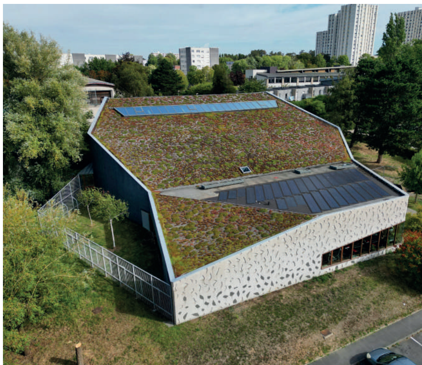
Panneaux photovoltaïques et végétation recouvrent le bâtiment du Polyèdre. Crédit photo : @HELLIX-IR
