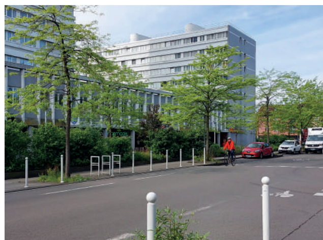
Jusqu'aux vacances de la Toussaint, des travaux seront opérés sur l'avenue Robert Schuman pour poursuivre le tracé de la piste cyclable.
