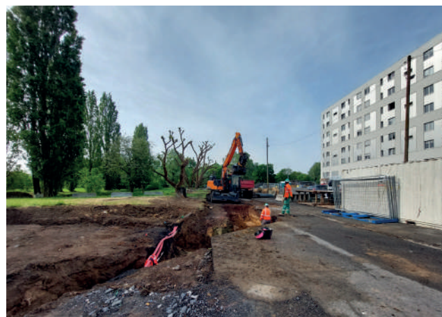
Les aménagements d'une nouvelle voie sont en cours.
