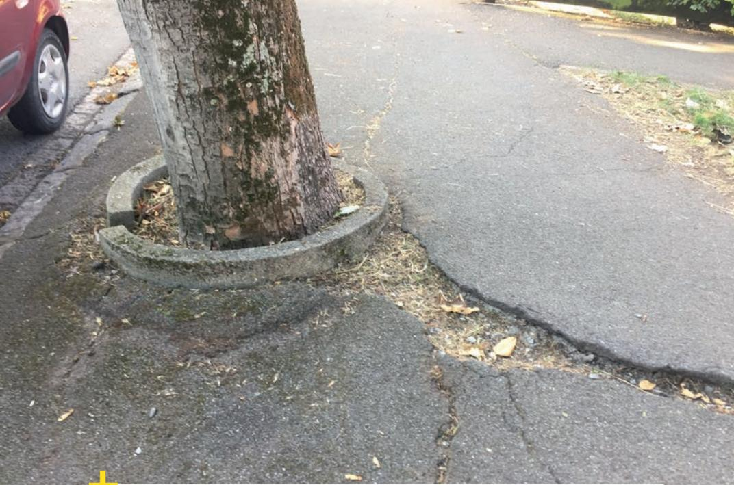
**+** Les racines des arbres peuvent faire de véritables dégâts sur la chaussée ou les trottoirs. Le remplacement des fosses est souvent difficile techniquement : présence de réseaux souterrains, largeur insuffisante des trottoirs...
