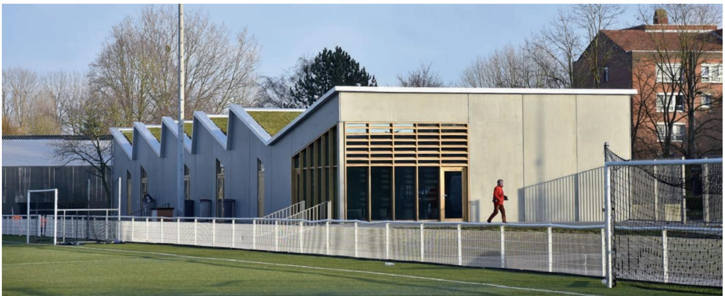
Les architectes ont fait le choix d'un type de toiture très particulier dite en shed, c'est-à-dire en dents de scie formée d'une succession de toits à deux versants de pente différente, le plus court étant généralement vitré.
