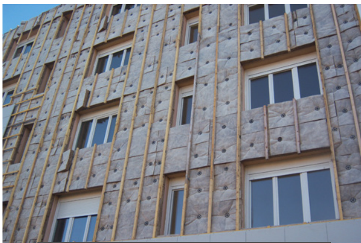
La résidence Renaissance en cours de réhabilitation thermique.
