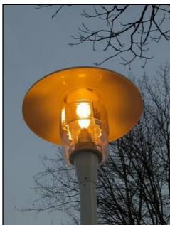
**Figure 12.** Ampoule Sodium basse pression
