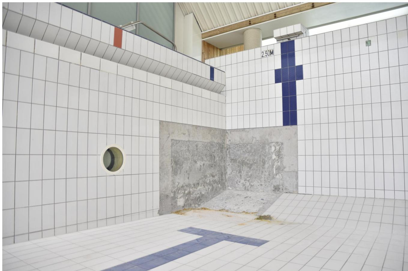
Aujourd'hui, les travaux de réparation de cette fuite peuvent reprendre. Après des recherches sur l'origine de la fuite, la zone endommagée du grand bassin va pouvoir être colmatée puis recarrelée.
