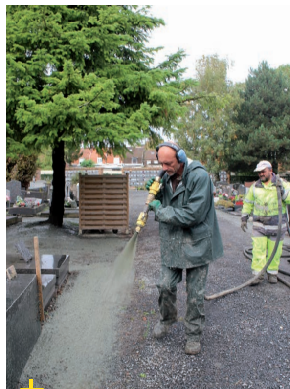
Opération d'hydromulching en cours.
